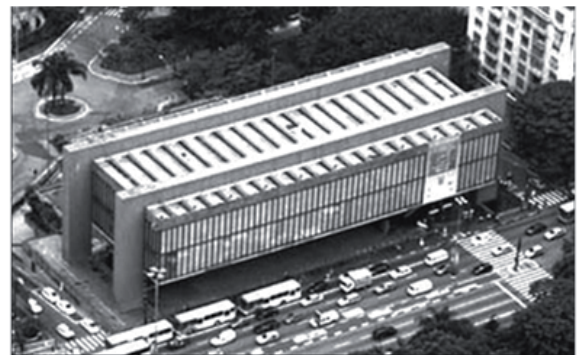
Figura 3. Foto da cobertura
